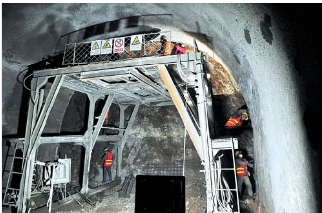
顺河高架路南延工程正在掘进的地道。 本报记者 周青先 摄
