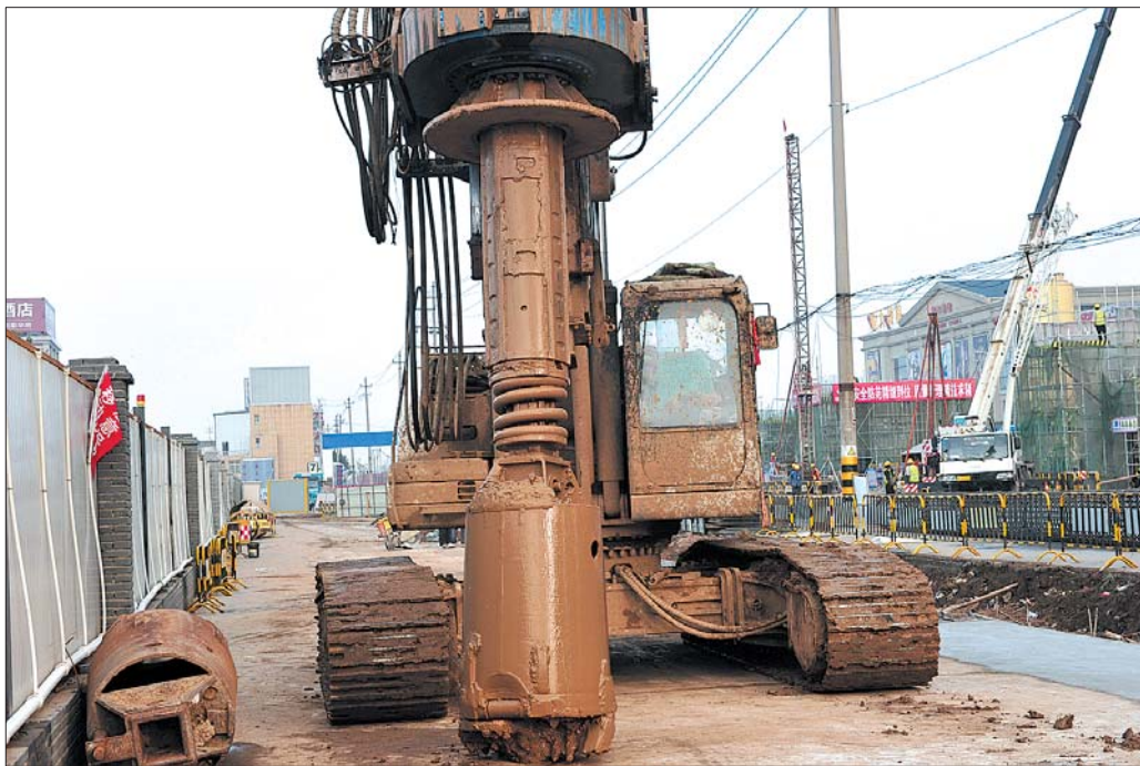
工业北快速路施工现场使用了新型旋挖钻。 本报记者 周青先 摄
