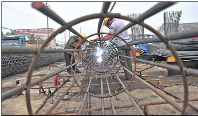
工业北路施工现场。 本报记者 周青先 摄
