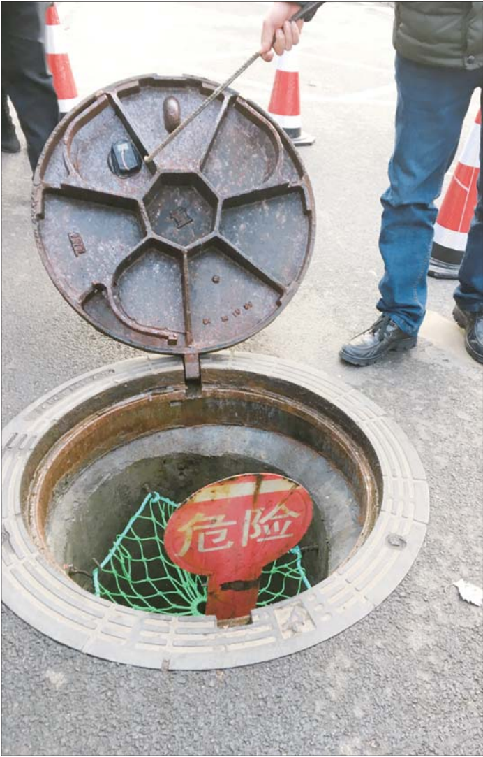
污水井盖打开后有多重防护,井盖上的小黑盒就是自动报警装置。 本报记者 王皇 摄
