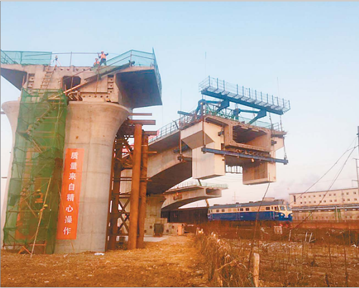
济青高铁淄博特大桥跨张东铁路连续梁转体成功。
