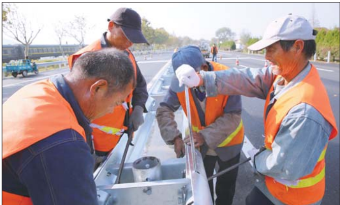
204国道新安装中央隔离护栏保障行车安全。 通讯员供图
