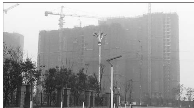
济宁城区的建筑工地已停工。本报记者 贾凌煜 摄
