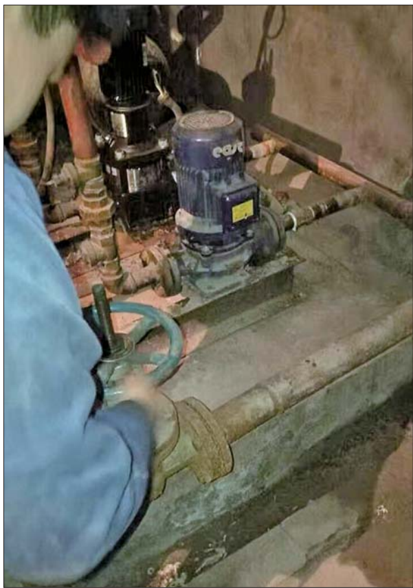
工作人员正在检修供暖设备。
