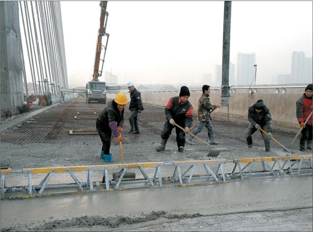
桥面进行混凝土铺装。 本报记者 邢孟 摄
