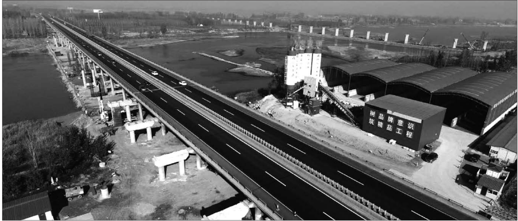
济青高速改扩建 潍河特大桥施工现场航 拍。(项目部供图)
