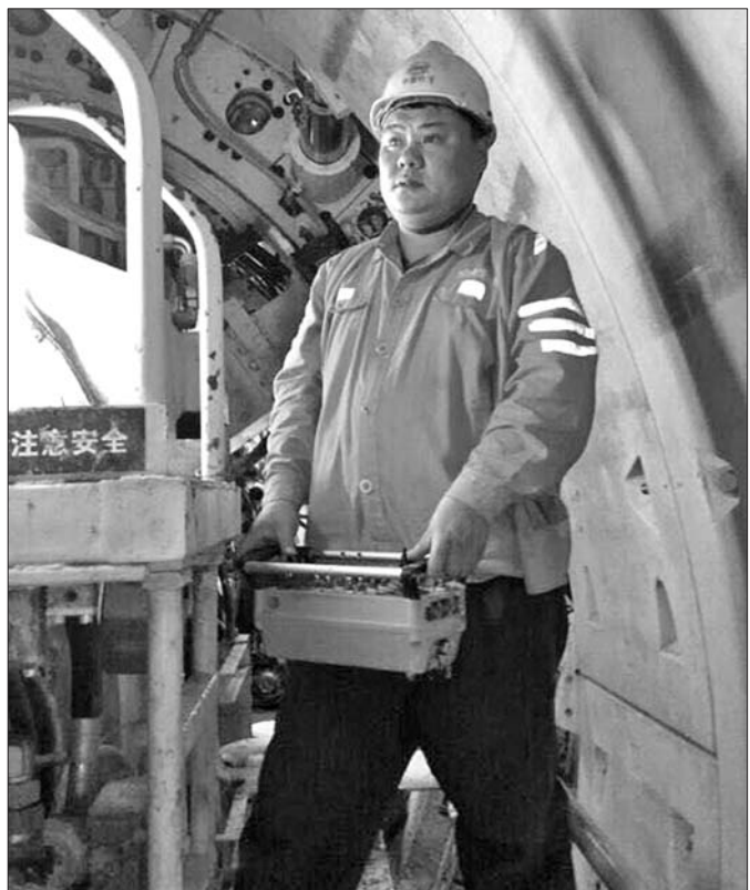
李金奎正在为盾构机新拓展出的隧道贴管片。 本报记者 韩笑 摄
