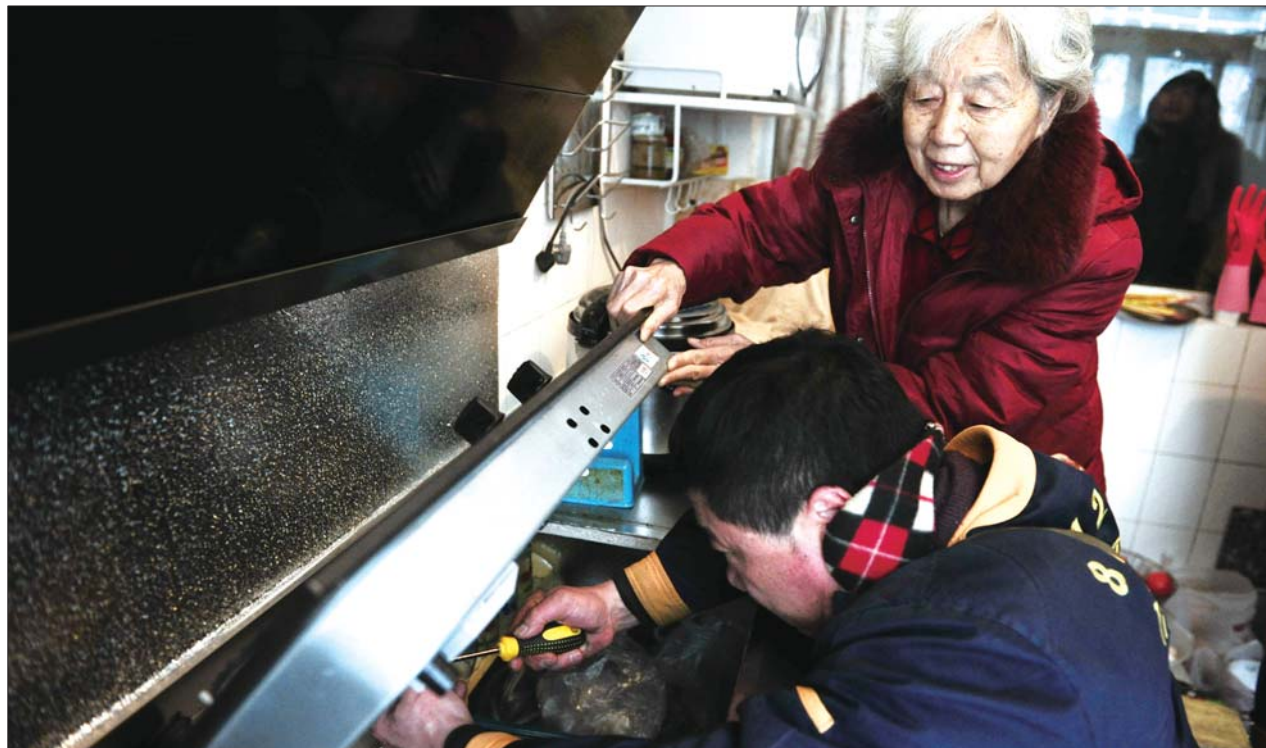
蓝光工作人员给居民更换管线。本报记者 戴伟 摄
