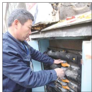
济南水务集团工作人员正在社区检查户表防冻设施。(资料片)
