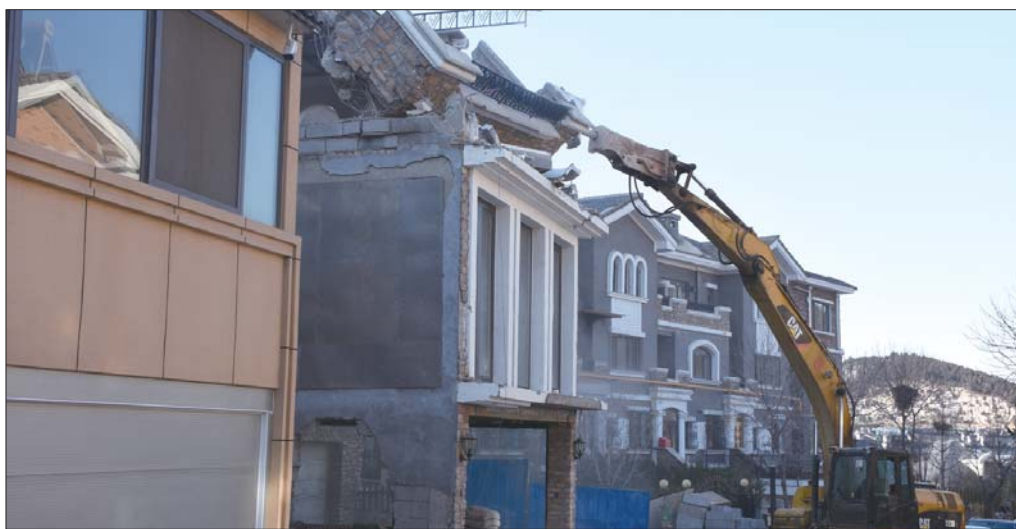
22日，城管执法人员对违建别墅进行拆除。
