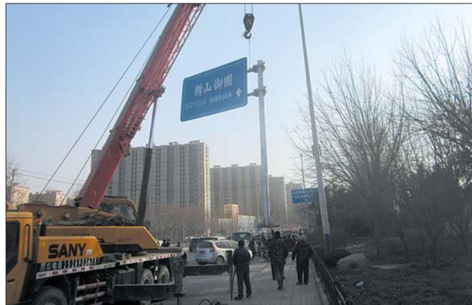
槐荫区拆除高铁沿线党杨路违法户外广告。 通讯员 李国兵 摄
