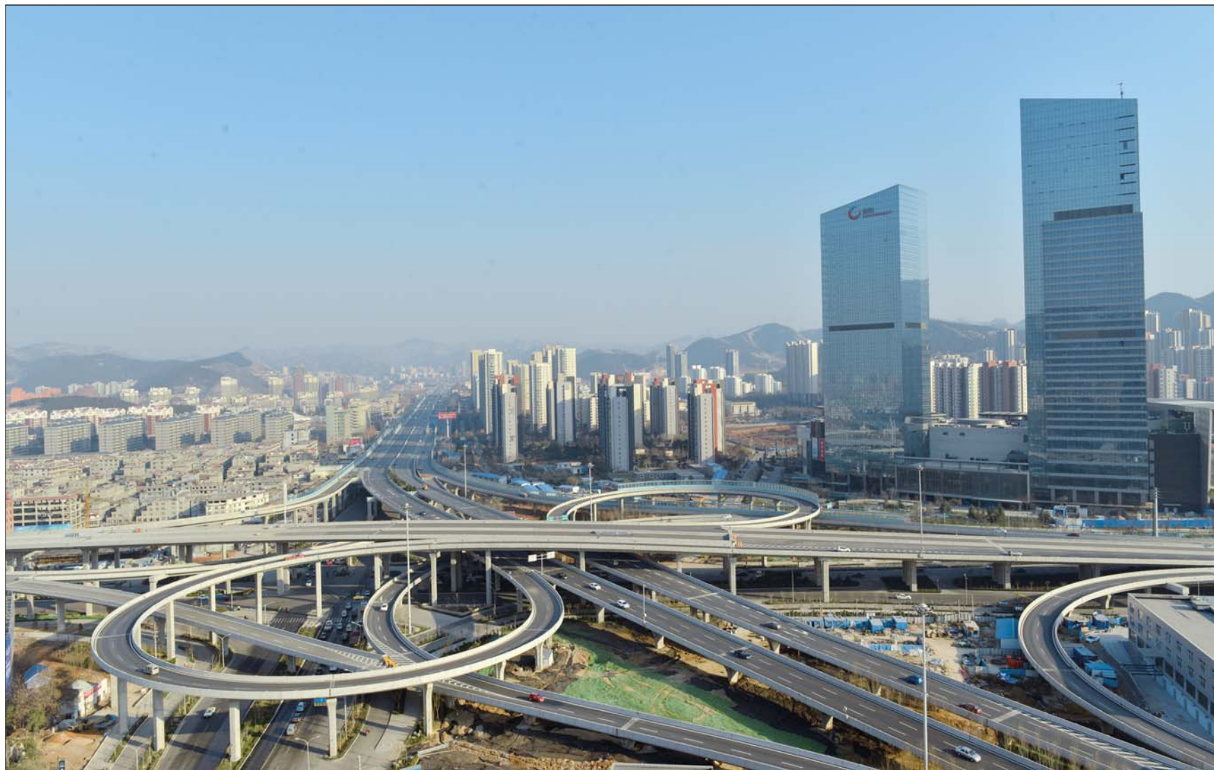
二环南路高架桥项目。市中区供图
