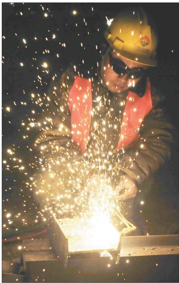
地下隧道里,工人在用气枪切割钢铁构件,喷溅出的火花犹如过年的礼花。
