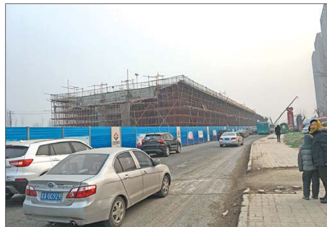
工业北路快速路正在加紧施工。本报记者 王皇 摄
