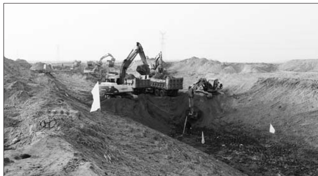
“黄水东调”潍坊段施工现场。本报记者 孙彬 摄
