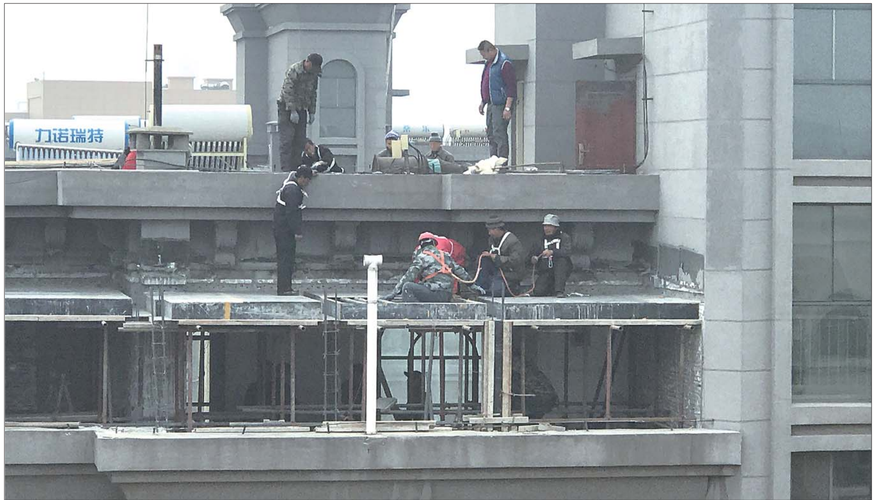
▲楼顶的违建刚刚搭起框架,城管组织工人拆除。市中城管供图
