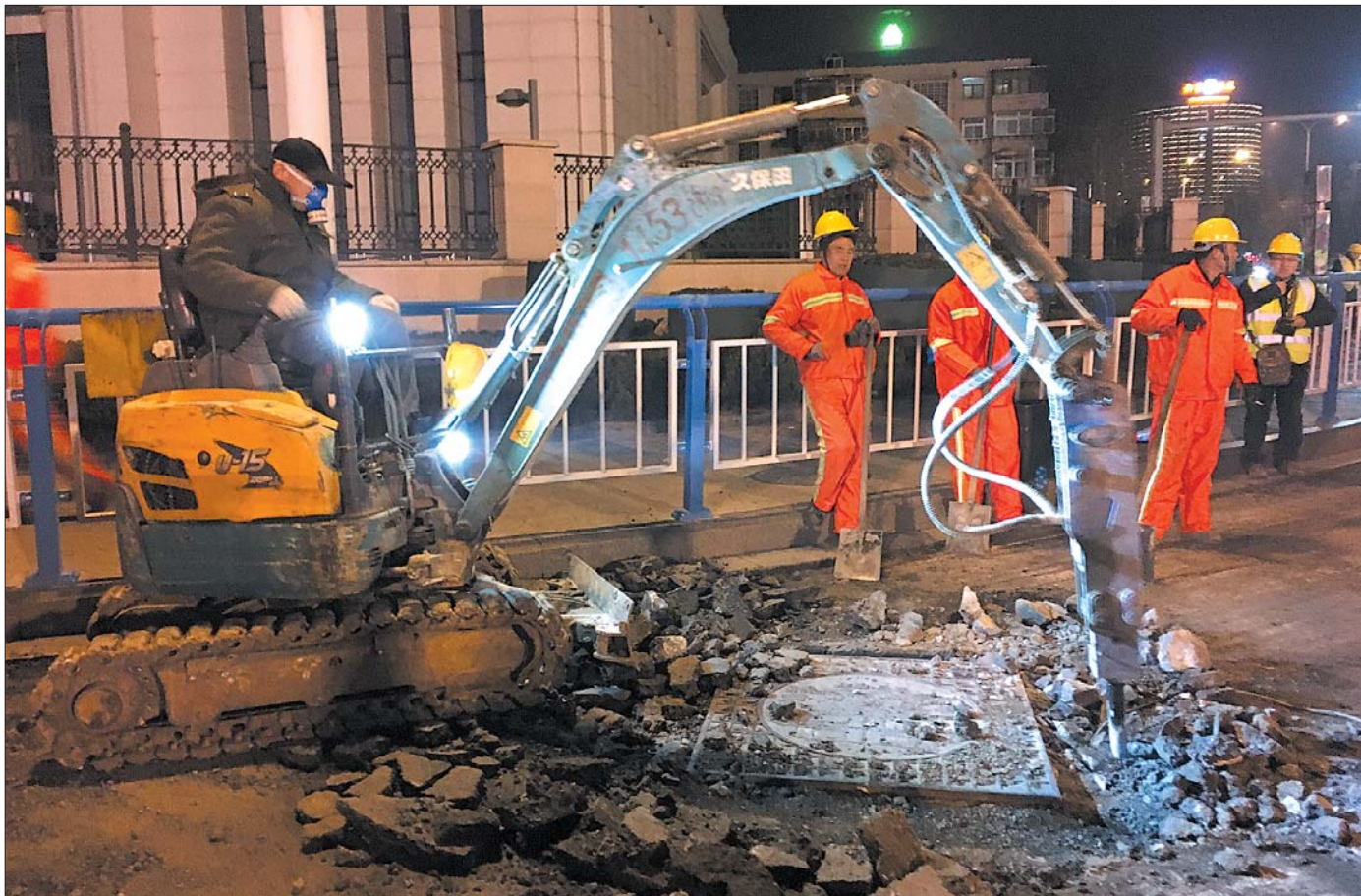
经十路舜耕路路口,道路养护人员正在加固井盖、维护破损路面。
