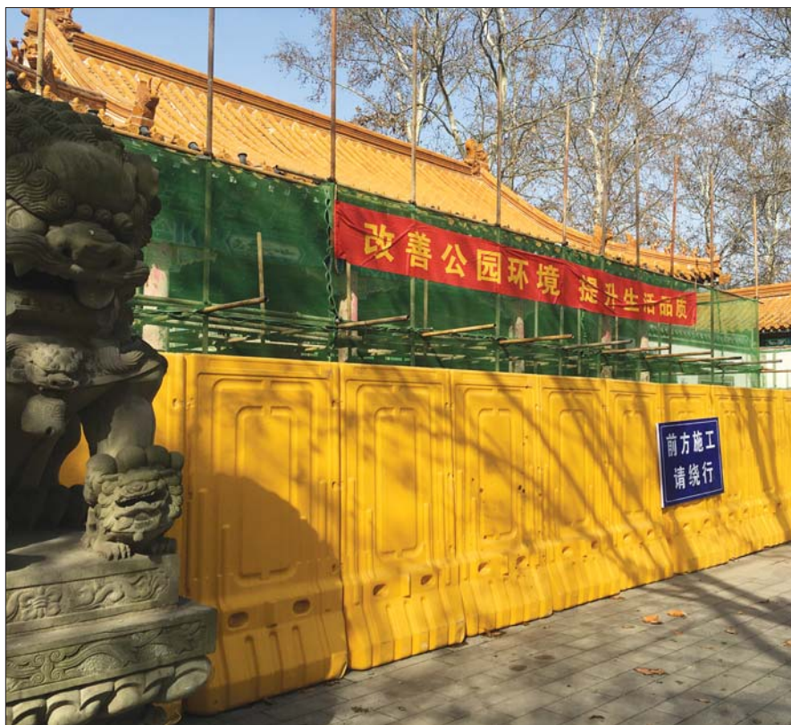
济宁人民公园东大门搭起脚手架。本报记者 贾凌煜 摄
