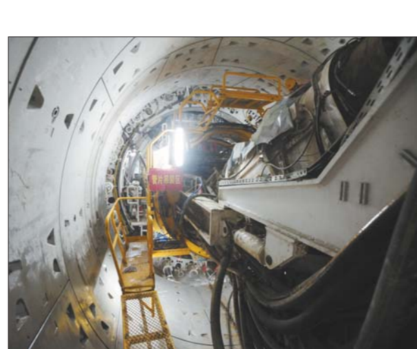
盾构机在地下作业。 本报记者 周青先 摄
