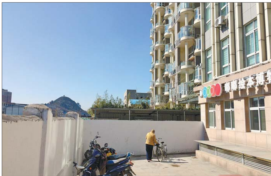
通往地下菜市场的路被两米高的墙堵住。
