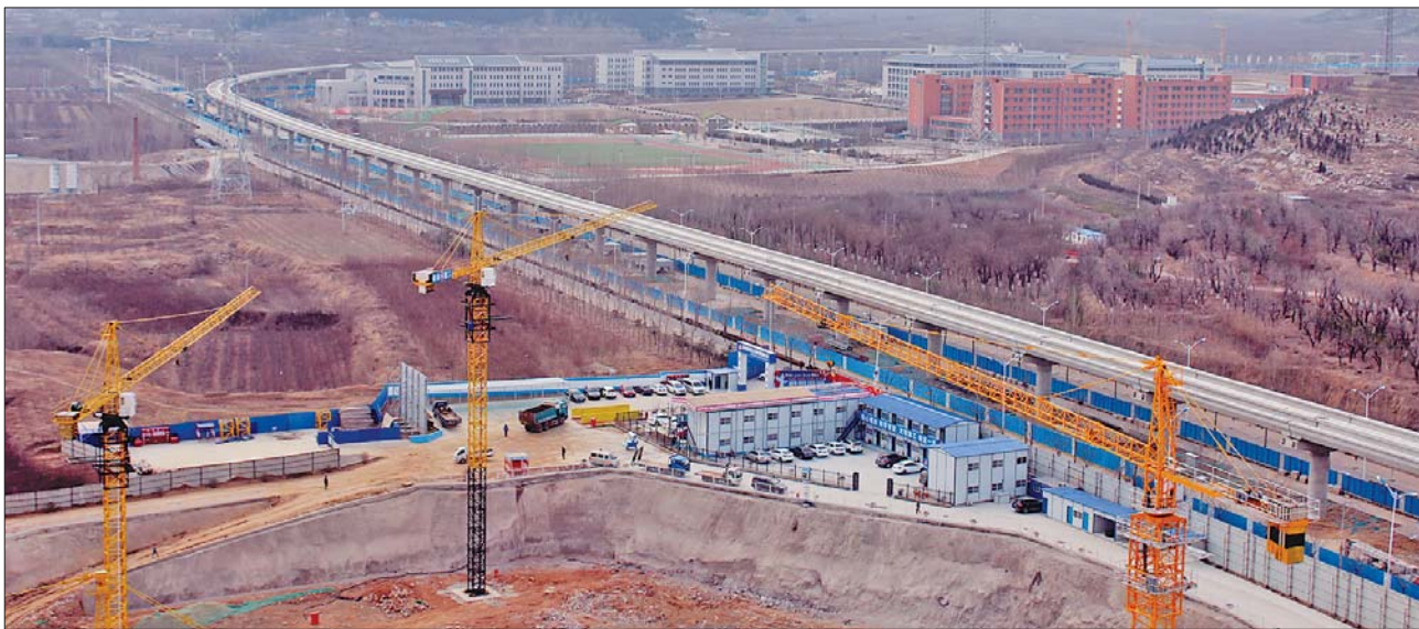
毗邻轨交R1线的创新谷孵化器二期项目正在建设中。
