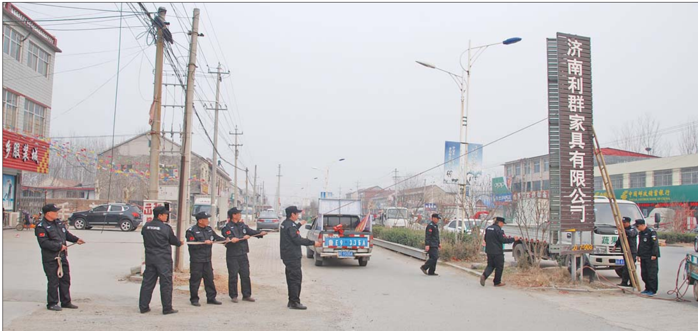
孙耿镇“拆违拆临”现场。 吴莎莎 摄
