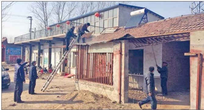
垛石镇“拆违拆临”现场。 杜敏 摄
