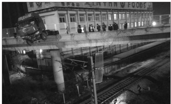
大货车撞坏立交桥护栏,悬在半空中。通讯员供图
