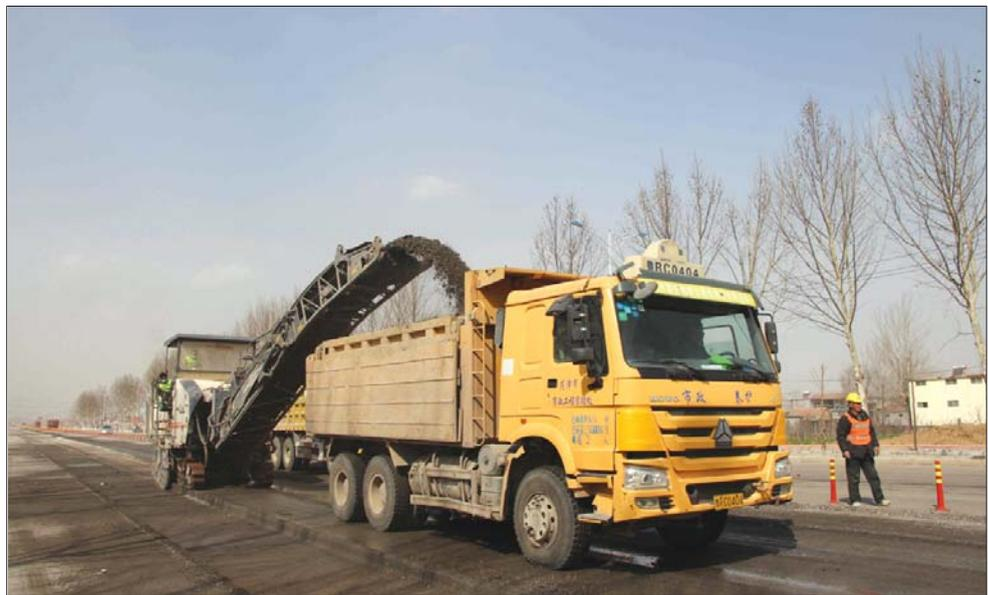
近日,记者在中华西路与水库西路交叉口看到,铣刨基层工作正在紧张进行,提升改造工程进展顺利。目前,非机动车道、人行道、雨水、污水、路灯等工程现已基本完工,快车道铣刨、两侧绿化带上土及栽种苗木正在施工。
