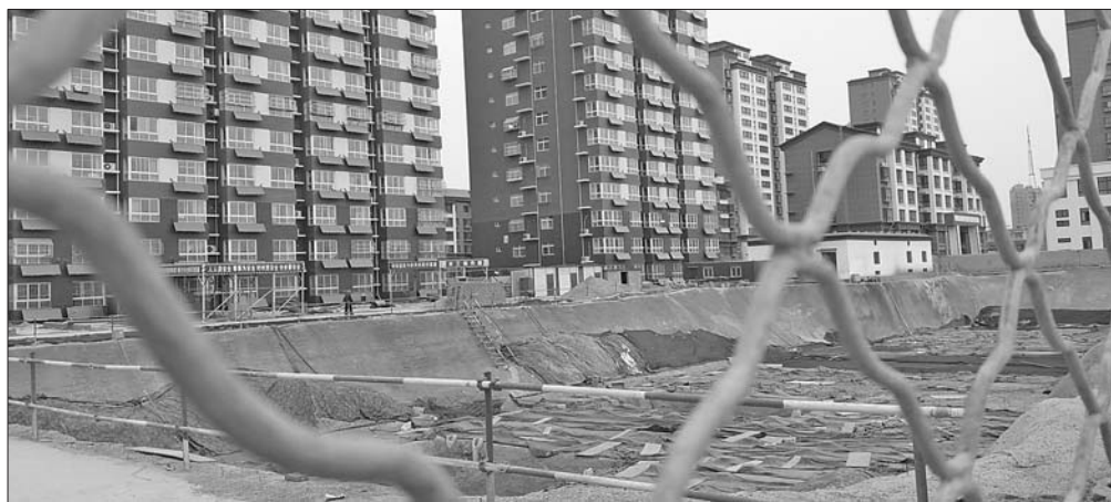
一小区建筑施工工地处于停工状态。 本报记者 张跃峰 张超 摄
