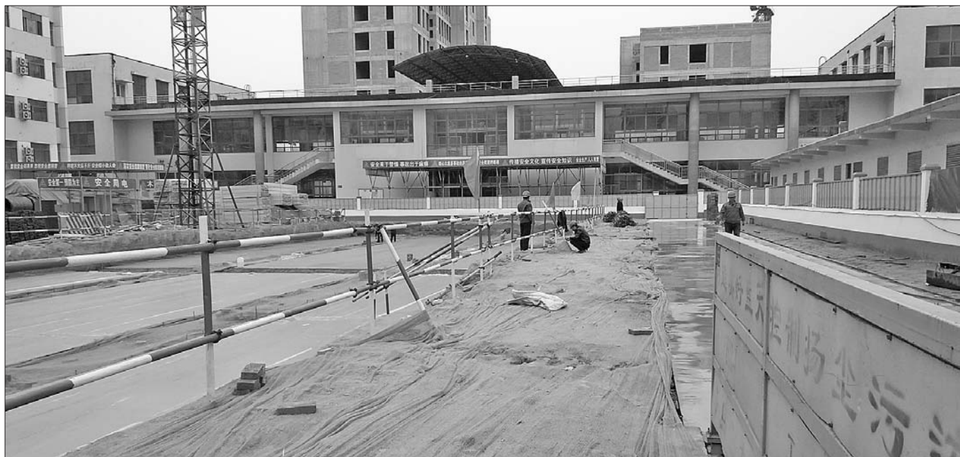
恢复施工的山东工程技师学院明德苑3号楼建筑工地，裸露土地已用防尘网覆盖。 本报记者 张跃峰 张超 摄
