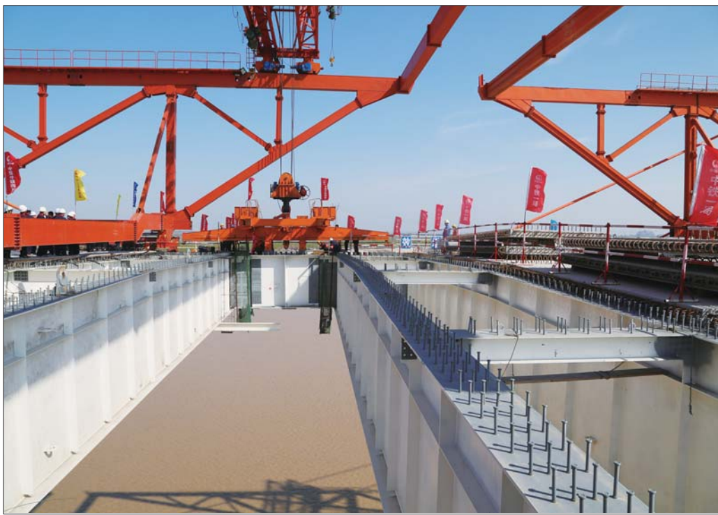
3月26日上午,济齐黄河大桥主桥顺利合龙。
