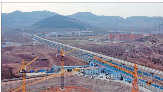
毗邻轨交R1线的创新谷孵化器二期项目正在建设中。
