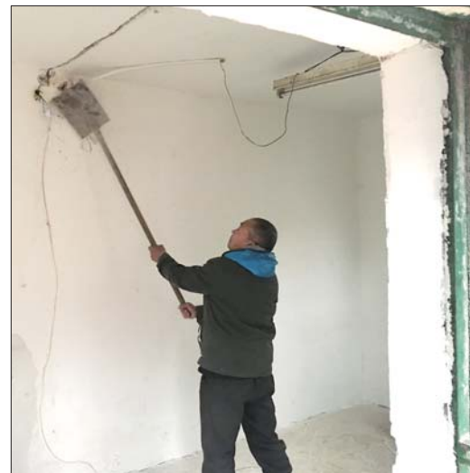
茂新社区2号院居民自拆违建。
