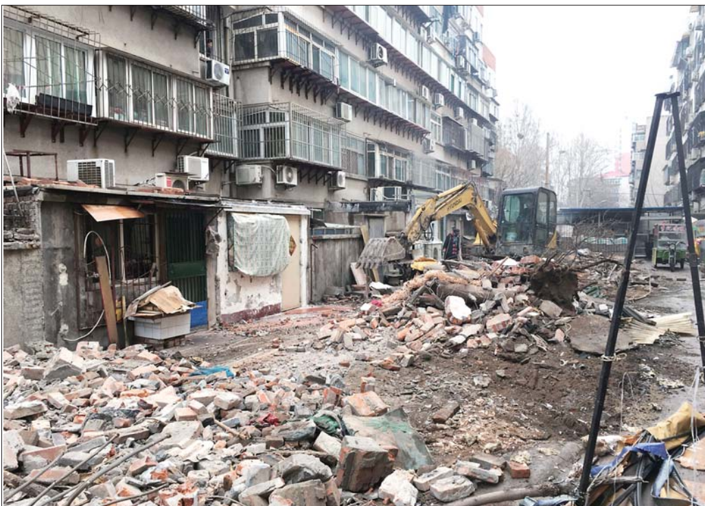
纬北路街道办聚贤社区10号院拆除储藏间。
