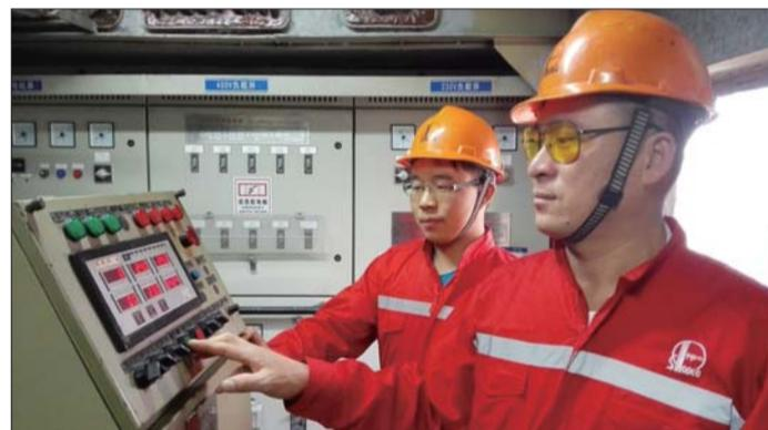
应急发电机自启动功能测试。
