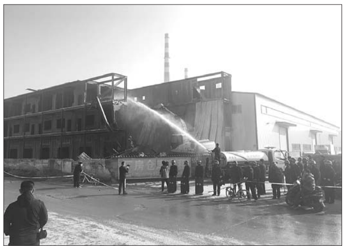
铁路沿线违法钢结构开始拆除。 本报记者 孙业文 摄
