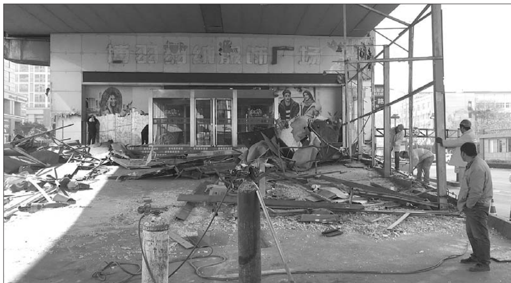
顺河高架下羽绒服广场正在拆除。 本报记者 张阿凤 摄
