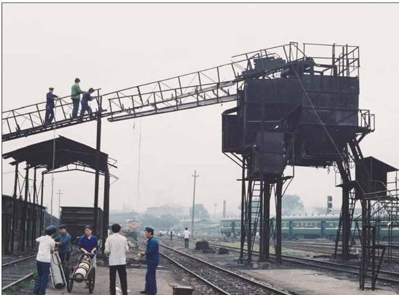
济南机务段拆除上煤台的场景。张汝峰 摄
