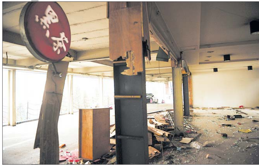
舜和茶城 一楼已拆完, 二楼连夜拆
