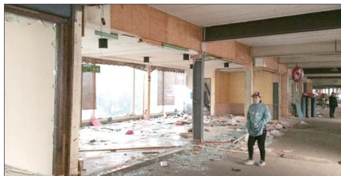
5日下午,舜和茶城一楼,玻璃外墙和部分内部装饰已经拆除。
