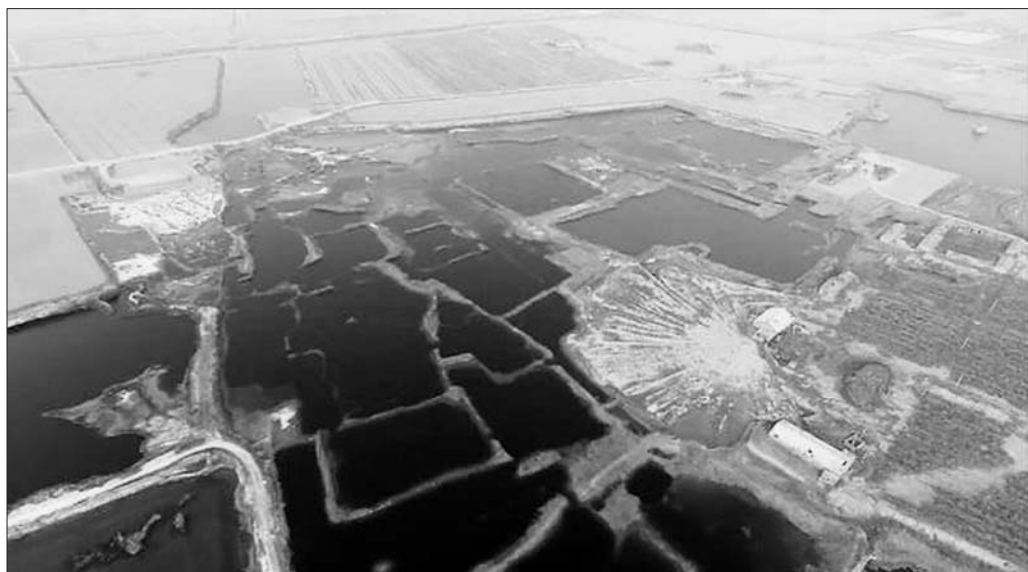
大城县一处渗坑俯瞰图。
