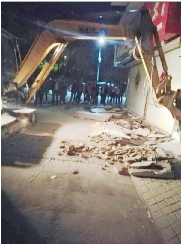
香江违建拆除现场。
