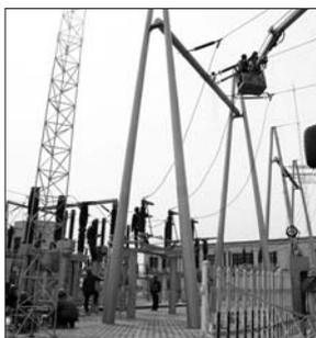
4月10日,武城县供电公司组织人员对110千伏白庄变电站进行设备清扫、母线更换及继电保护装置调试等检修消缺工作,通过精益化治理消除设备隐患,努力打造坚强电网,确保“迎峰度夏”期间电网安全稳定运行。本报通讯员 郑智慧 杨加明 摄
