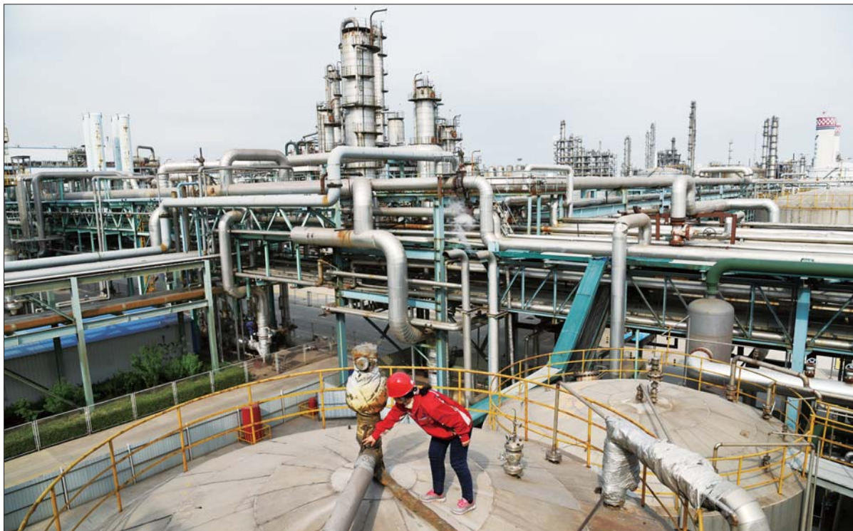
在乙二醇装置三层平台的罐顶上进行检查作业。
