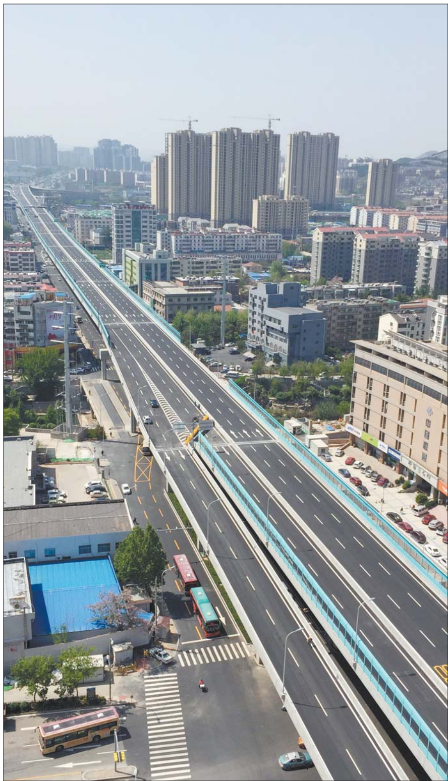
26日,顺河南延一期高架路静候27日凌晨正式通车。
