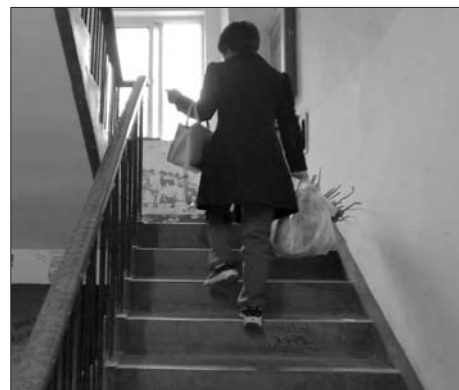
电梯停用,市民只能走楼梯。
