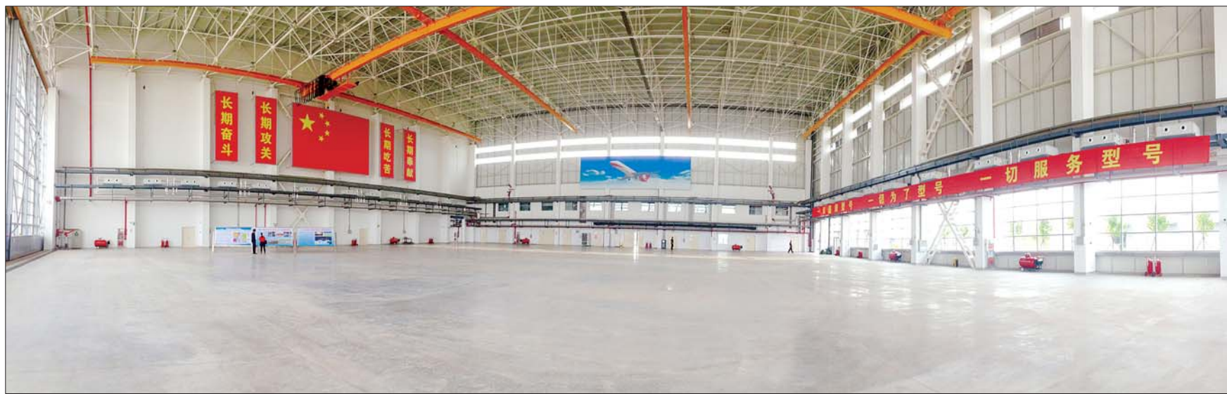
站在高24米、跨度54米+54米、进深63米的试飞调整机库内,人立马变得矮小许多。 本报记者 段学虎 摄
