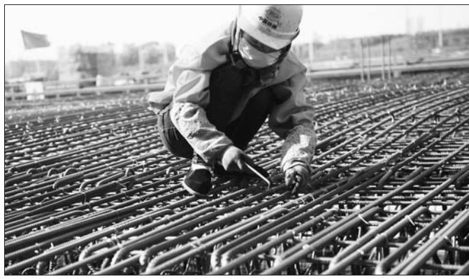
高铁梁场，工人把钢筋组成的笼子绑到架子上。 本报记者 戴伟 摄
