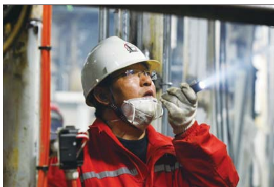
精细检查每一道焊缝。
