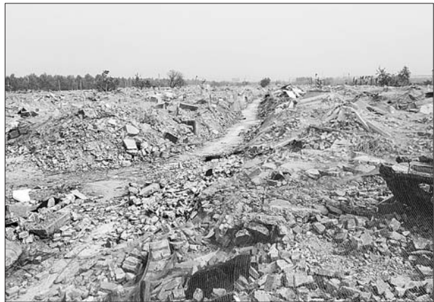
章丘山大片区已拆迁完毕。本报记者 张刚 摄
