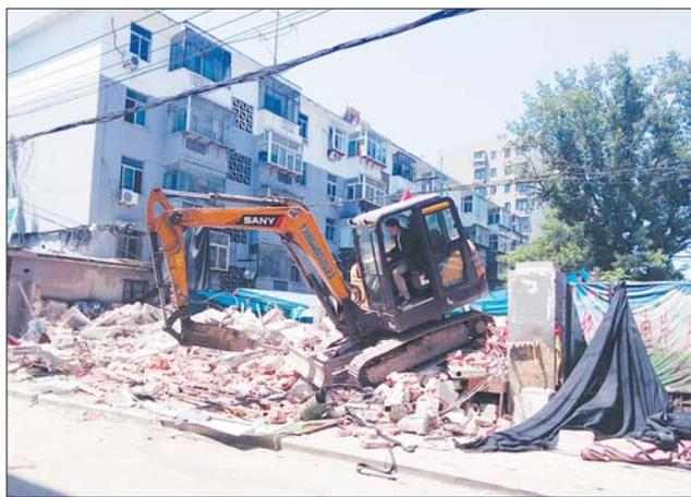
壁凿开,然后挖掘机再顺势推到墙壁。现场的违建房屋已经拆除了一部分,挖掘机也继续向前挺进。
