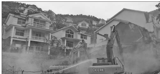
第一次大行动:5月11日,南部山区西营镇拆除首批青龙峪违建别墅17栋。
