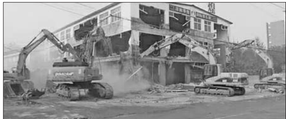
济北街道依法对“火耕”实施强制拆除。(资料片)
