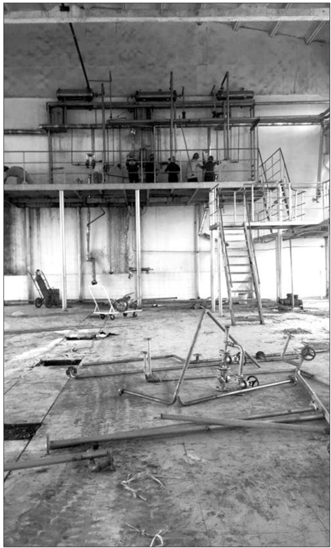
山东利蒙药业有限公司正在拆除中。 本报记者 张玉岩 摄
