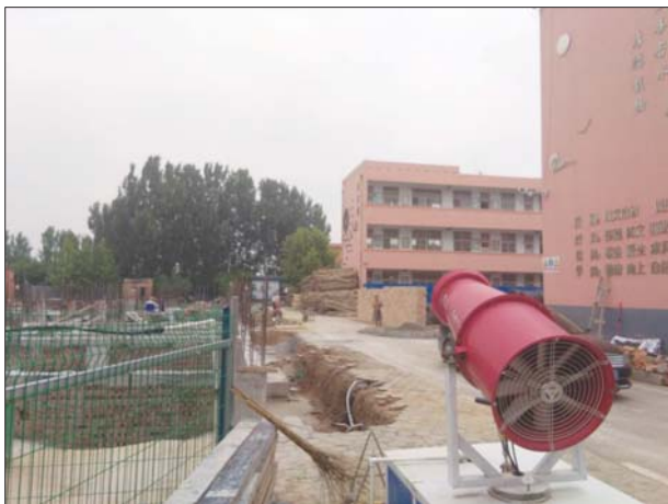
在冠县一处学校,施工人员进行热火朝天地进行施工。 本报记者 张跃峰 摄
